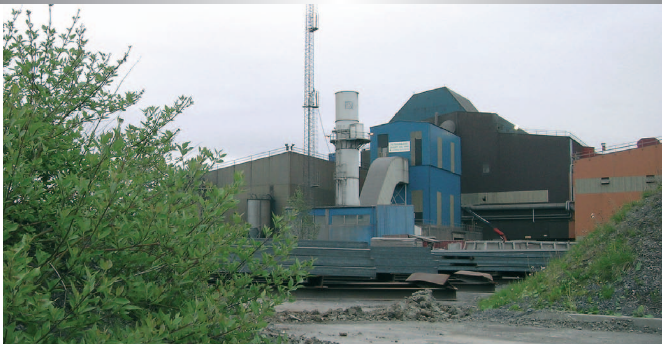
Celsa Armeringsstål overvåker utslippene av støv og andre utslippselement fra begge verkene. Mot toppen av pipa til renseanlegget på stålverket er det montert en testestasjon som måler utslipp av kvikksølv 24 timer i døgnet.
