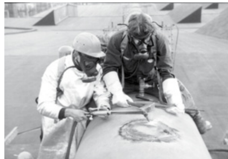
Sveising med gassmaske på CO-gassledningen, oppe på taket til Valseverket.
