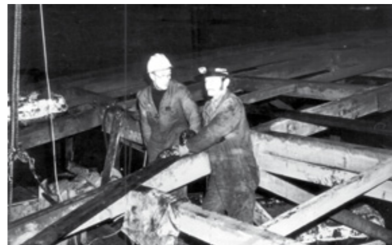
Å jobbe inne i gassklokka er et arbeid som er tidkrevende og utfordrende. I dag er det påbudt med fullt røykdykkerutstyr på grunn av det farlige støvet og den giftige gassen. Her er Sture Reinholdtsen med sveiselue.
