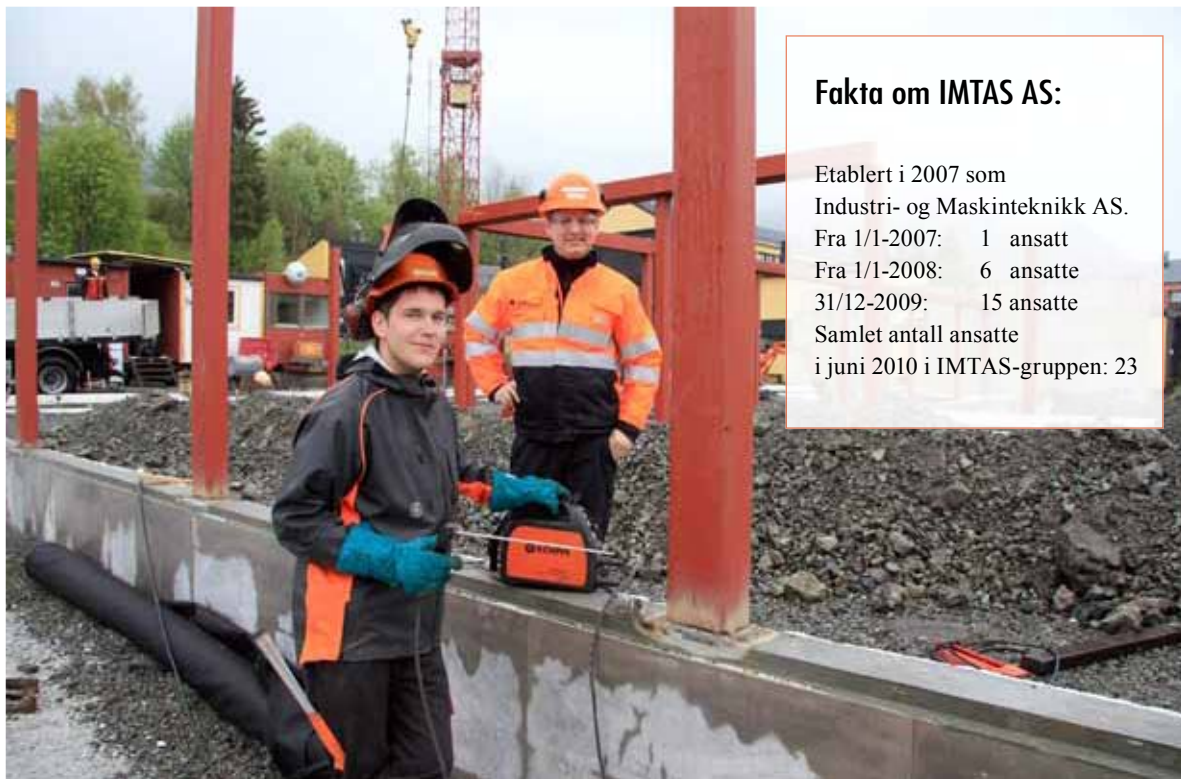
Montasjeleder Rune Nyjordet Nikolaisen (t.v.) og daglig leder Johannes Sandhei ved det hittil største oppdraget til IMTAS, stålkonstruksjonene til den nye rusenheten til Helgelandsykehuset.
