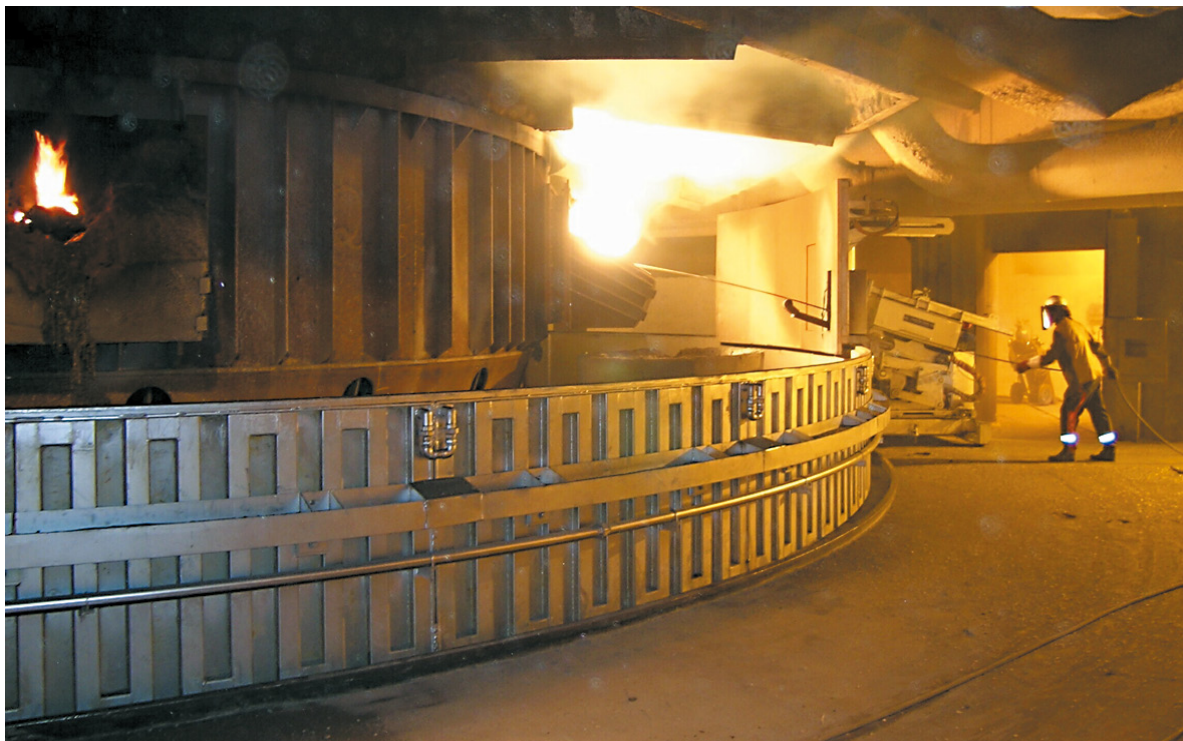
Ovn 5 er nå i normal drift etter ombyggingen. Det er nå god etterspørsel etter bedriftens produkter, sier verksdirektør Tommy Tunstad i Fesil AS, Rana Metall.
