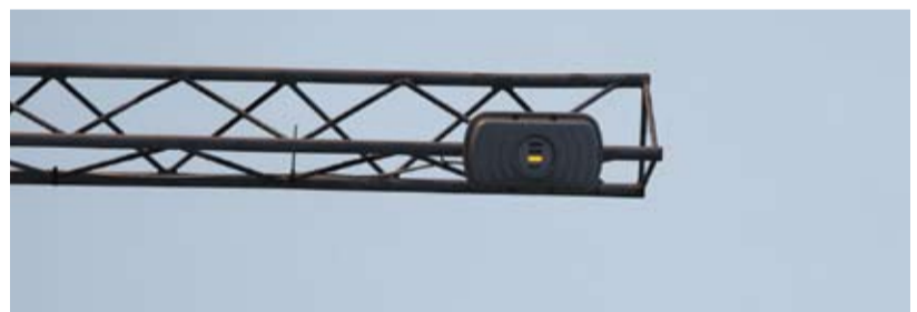
Se etter at leseren av bilbrikkene har blinkende lys. Da er signalet lest, og bommen vil gå opp etter få sekunder.
