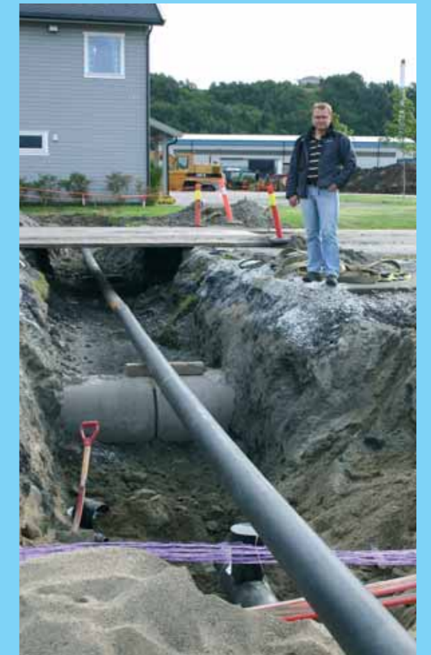
De siste rørledningene legges nå i høst i Vika. Derved kan fjernvarmenettet i Mo i Rana kobles sammen i en fjernvarmering.
