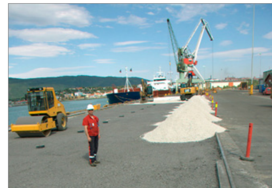
I 2009 ble toppdekket på betongkaia skiftet ut og erstattet med ny overbygning og asfalt
