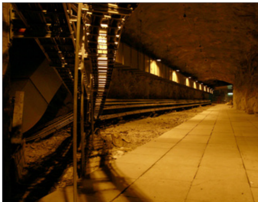
Kabelbruer inne i fjellet ved Svabo.
