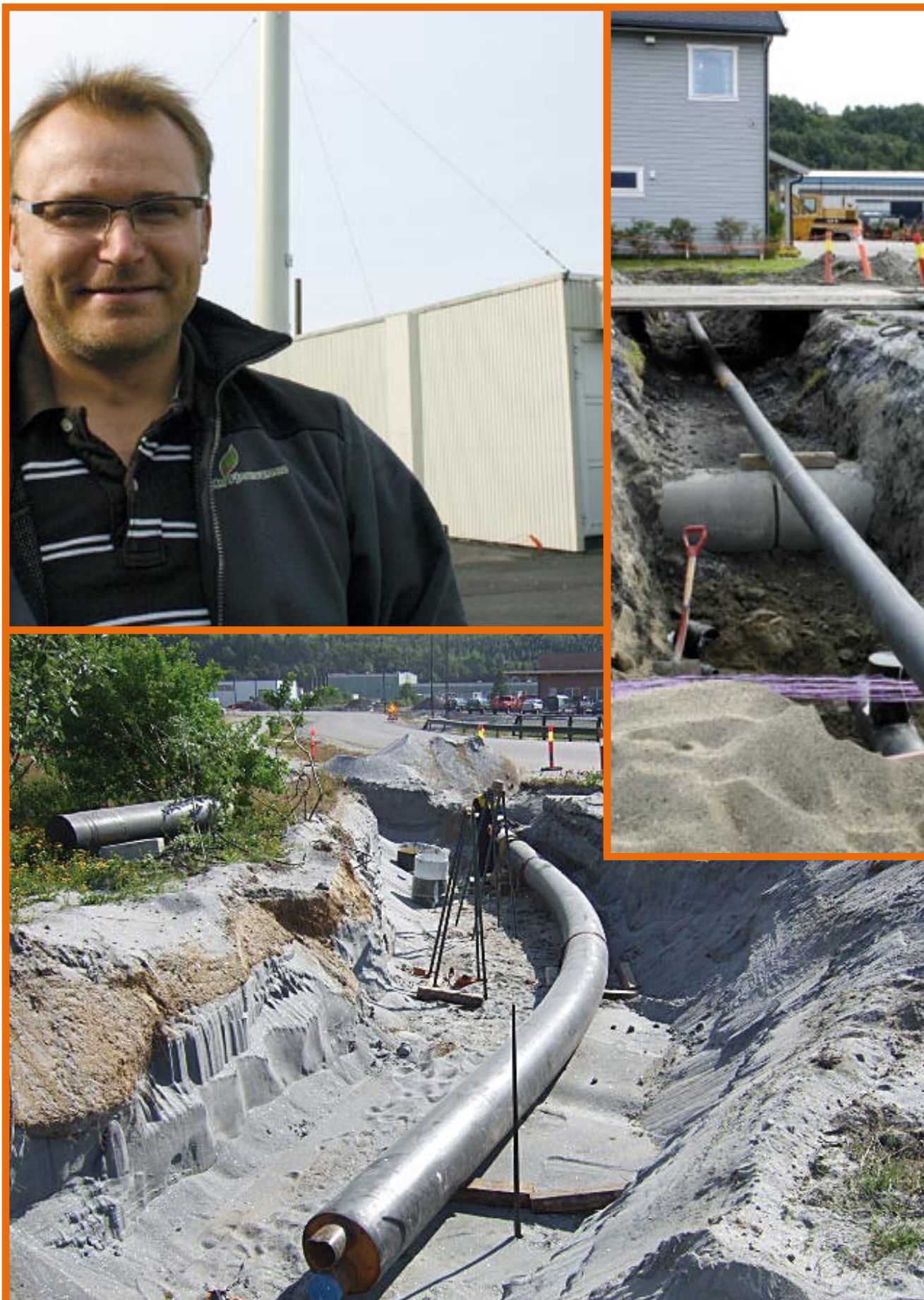
Mo Fjernvarme AS ferdigstilte utvidelsen av fjernvarmenette til Selfors/Vikaområdet. Inklusive Tverråneset, Ranenget og Mjølan.
