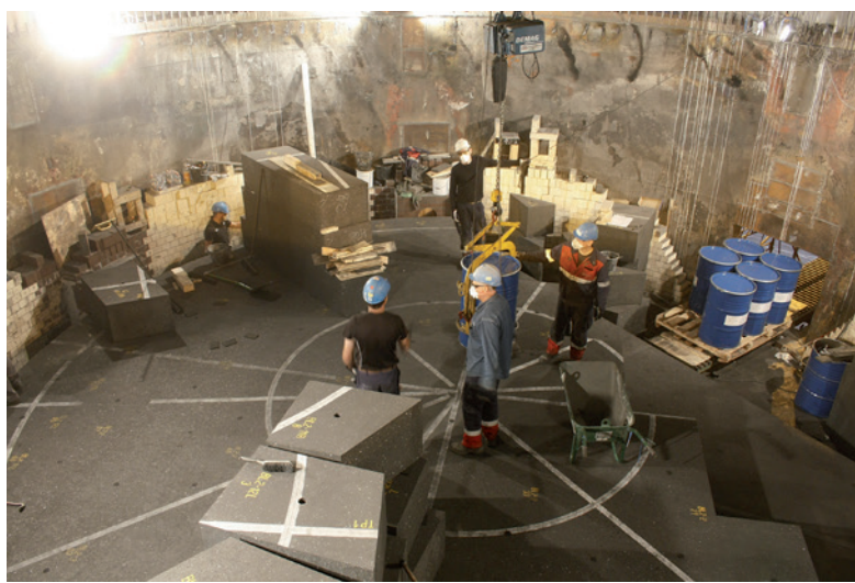
Alt gods til ommuring av ovn 6 ble sendt inn gjennom luka i ovnsveggen, en pall om gangen, på det lille rullebordet der pallen med de blå tønnene står. I alt var det om lag 700 paller som ble tatt inn på denne måten, og i tillegg ble alt av arbeidsutstyr, verktøy, bindemiddel og mørtel tatt inn på samme måte.
