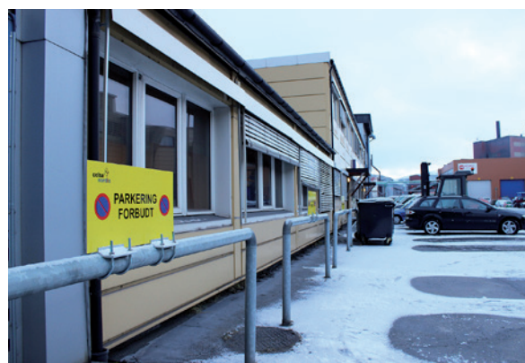
Celsa Armeringsstål AS har satt opp nye, markante skilt for å informere om parkeringsbestemmelsene ved administrasjonsbygget.
