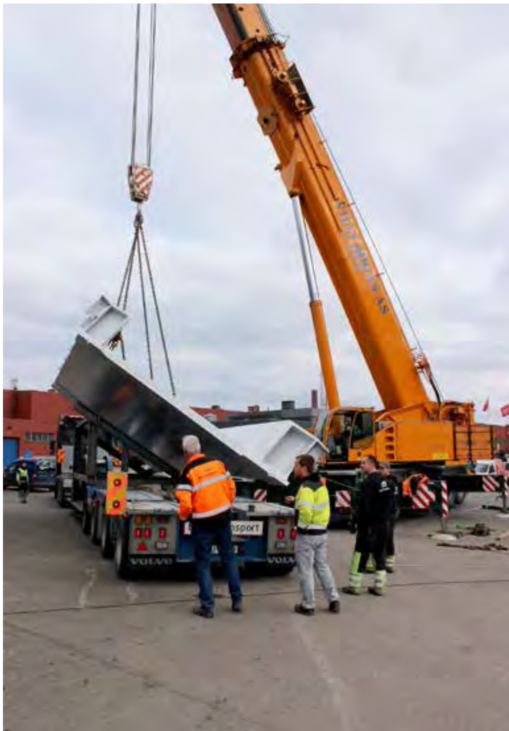
Den siste av de fem jernbanebroene lastes opp på trailer, for transport sørover.
