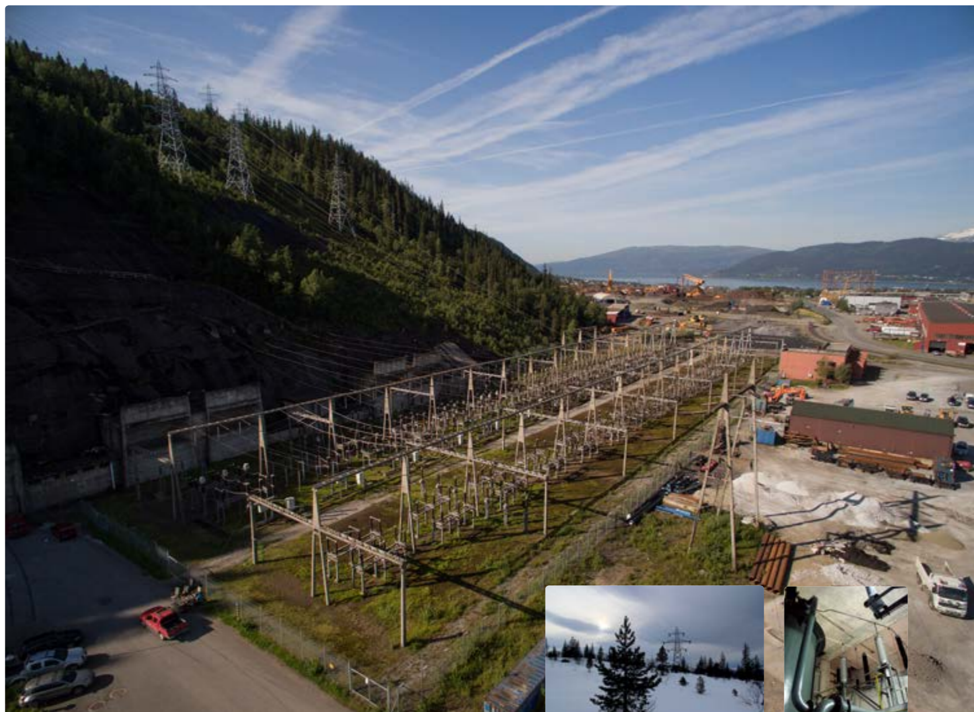
Svabo friluftsanlegg, med 132kV bryterfelt er tilknyttet sju (7) kraftlinjer fra overliggende nett, fem (5) hovedtransformatorer, samt koblings- og reservebrytere.
