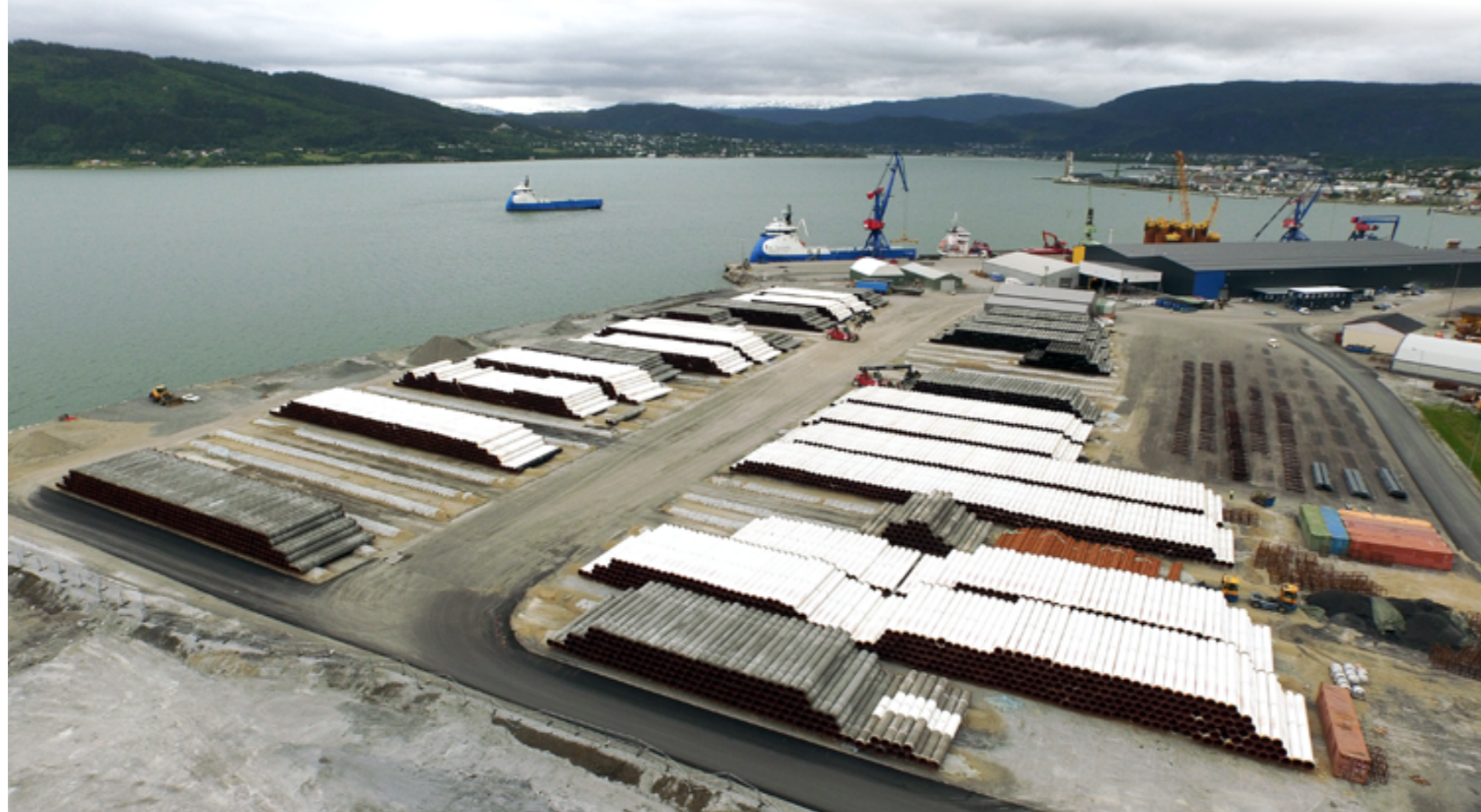
Sommeren 2015 var det flere daglige anløp av supplybåter som hentet rør for utskipping til Polarled; den 480 km lange rørledningen fra Nyhamna utenfor Molde og opp til Aasta Hansteenplattformen.
