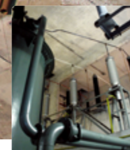
Det er svært høy redundans og god intern kraftforsyning i Mo Industripark.
