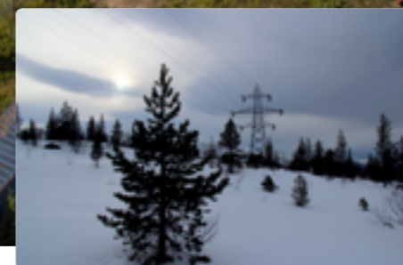
Mo Industripark har svært god linjeforbindelse med de store kraftverkene i Ranaregionen.
