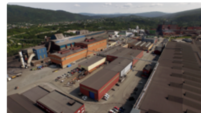
Mo Industripark AS har ledige verkstedlokaler midt inne i industriparken. Disse ble benyttet til produksjon av sugeankre for Aasta Hansteen-plattformen av Momek Fabrication AS, og ved prosjektavslutning i juni 2015 er de nå ledige for utleie.
