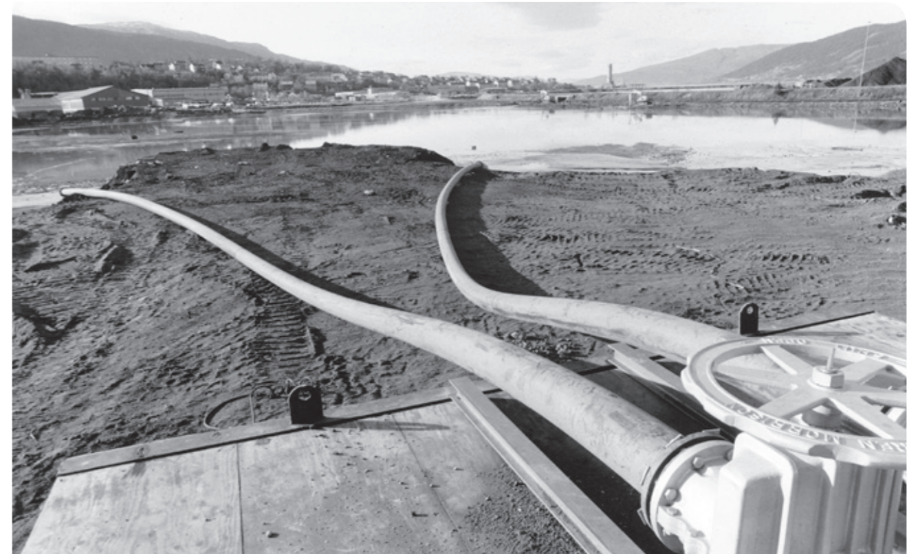
Avgangsmasse fra Rana Grubers oppredningsanlegg ble benyttet til utvikling av store nye områder mot fjorden fra 1987 til 1992, der områdene Søndre felt, Midtre felt og Nordre felt ga hele 655 dekar ny tomtegrunn til Mo i Rana. I alt ble det lagt ut 4,5 mill. tonn avgangsmasse.
