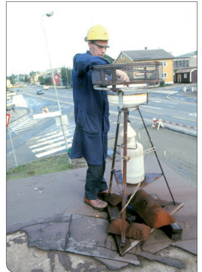
Fra 1967 ble det gjennomført omfattende kartlegging av nedfallsstøv i Mo i Rana og på Gruben. Bildet viser målepunktet i krysset mellom Sørlandsveien og Lars Meyers gate, en gang på 1970-tallet.
