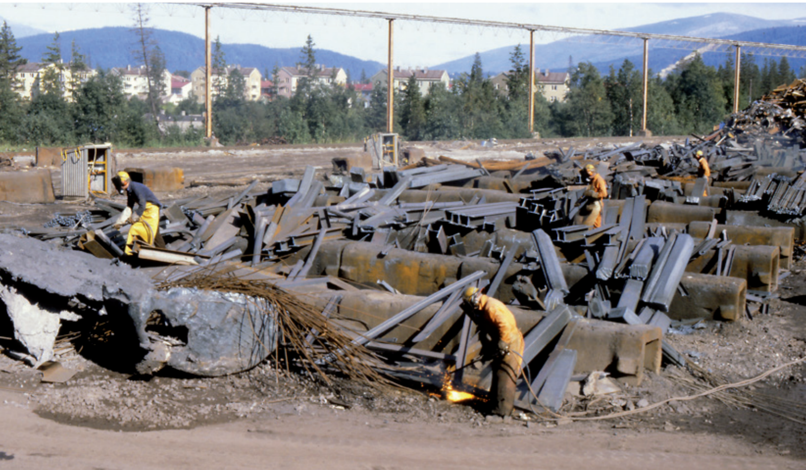
Gjennom hele 1970-tallet ble skrapprodukter fra valseverket kuttet opp manuelt med skjærebrennere. Et tøft arbeid, som ble utført utendørs, sommer som vinter. Med investering i skrapaks tidlig 1980-tall ble dette arbeidet utført maskinelt og med langt mindre ressurser og med høyere kvalitet.
