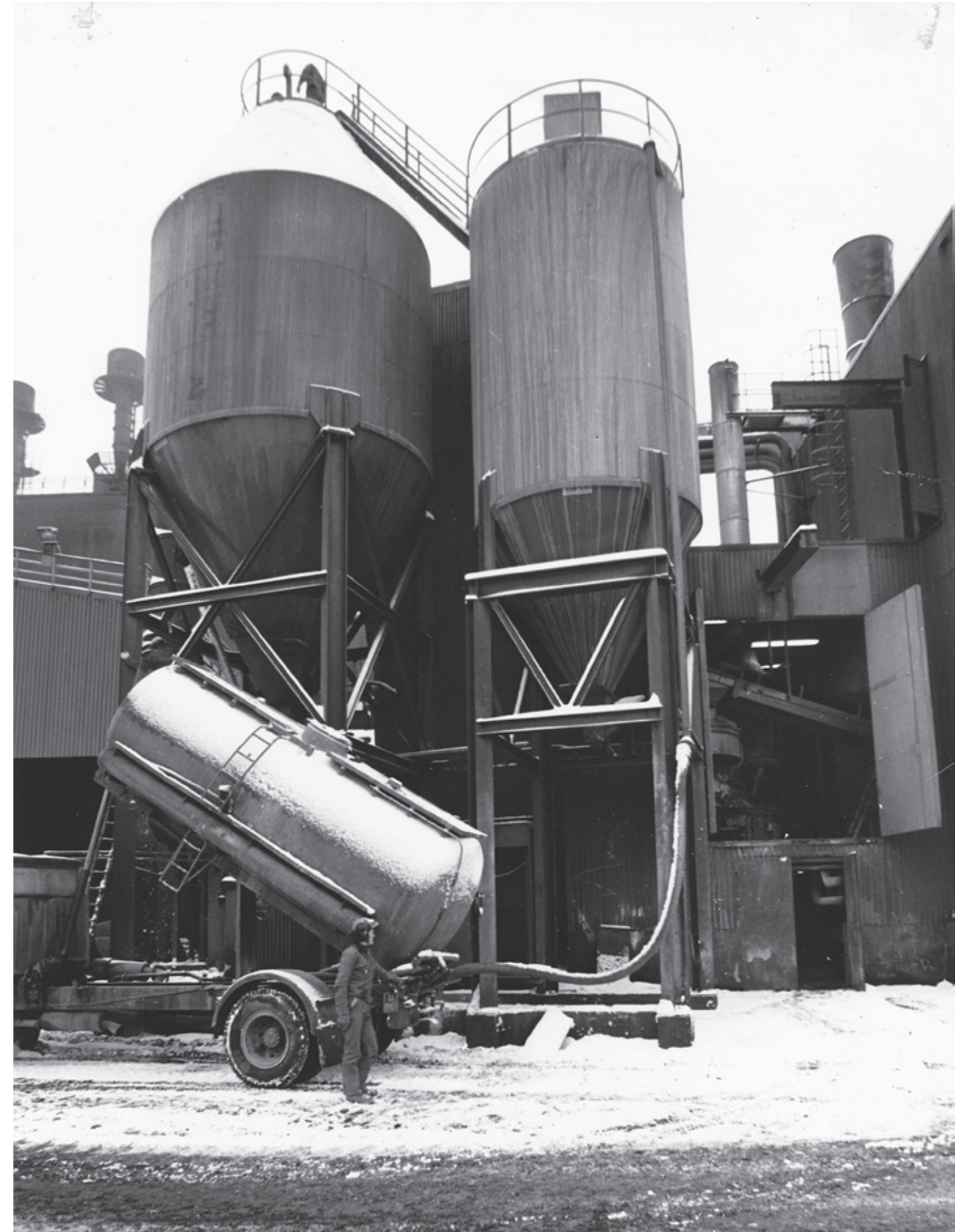
Rødstøv fra renseanlegget ved LD-verket overføres til tankbiler, for videre behandling. Med det nye renseanlegget for LD-verket i 1975 fikk man til slutt bukt med det store utslippene av rødstøv.
