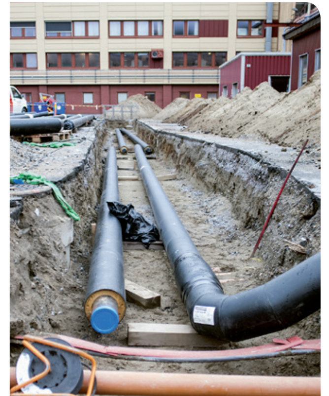
Det varme vannet transporteres under bakken gjennom 29 kilometer rør. Her legges det nye rør inne i Industriparken.
