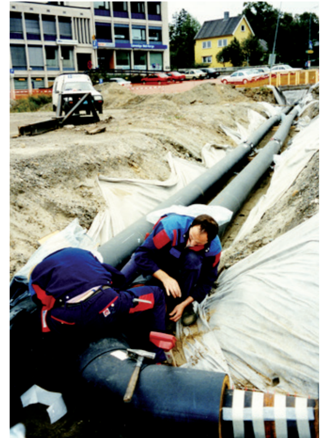
De første fjernvarmerørene ble lagt ut i byen i 1986. Bildet viser rørlagging foran Rana Rør-gården, der Rana Blad i dag har sine lokaler.
