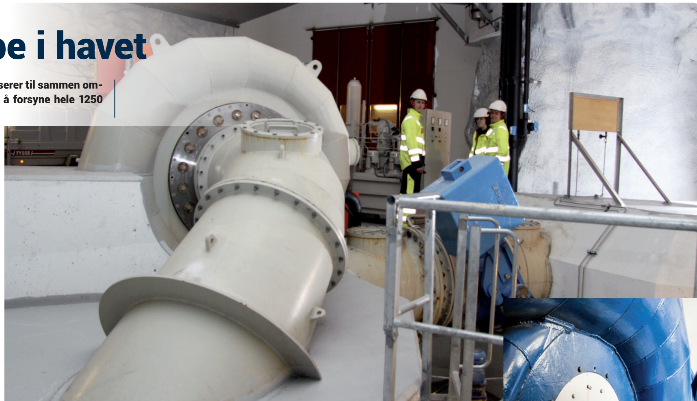
Turbinen i Svabo kraftverk (over) produserer omlag 20 GWh strøm i året.
