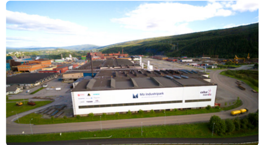
Oppgradering av fasaden på stripperhallen har gitt Mo Industripark en visuell ansiktsløftning, og gjort industriparken meget synlig i bybildet.
