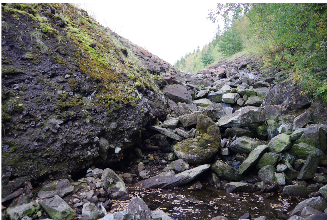
Figur 25 Avslutning av bekkeplastring i Mobekken. Deponimasser fra deponi 13 sees til venstre.
