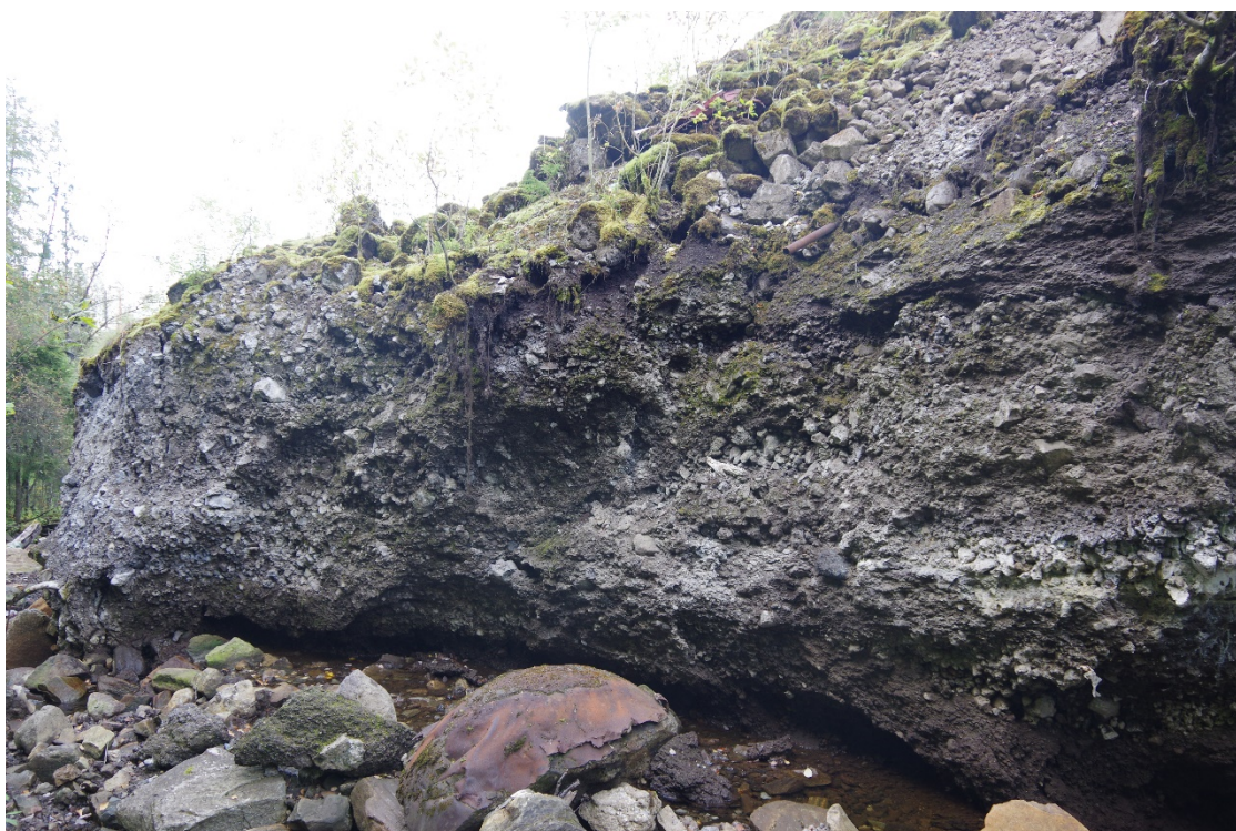
Figur 26 Fyllmasser i deponi 13 blottlagt i bekkefare.
