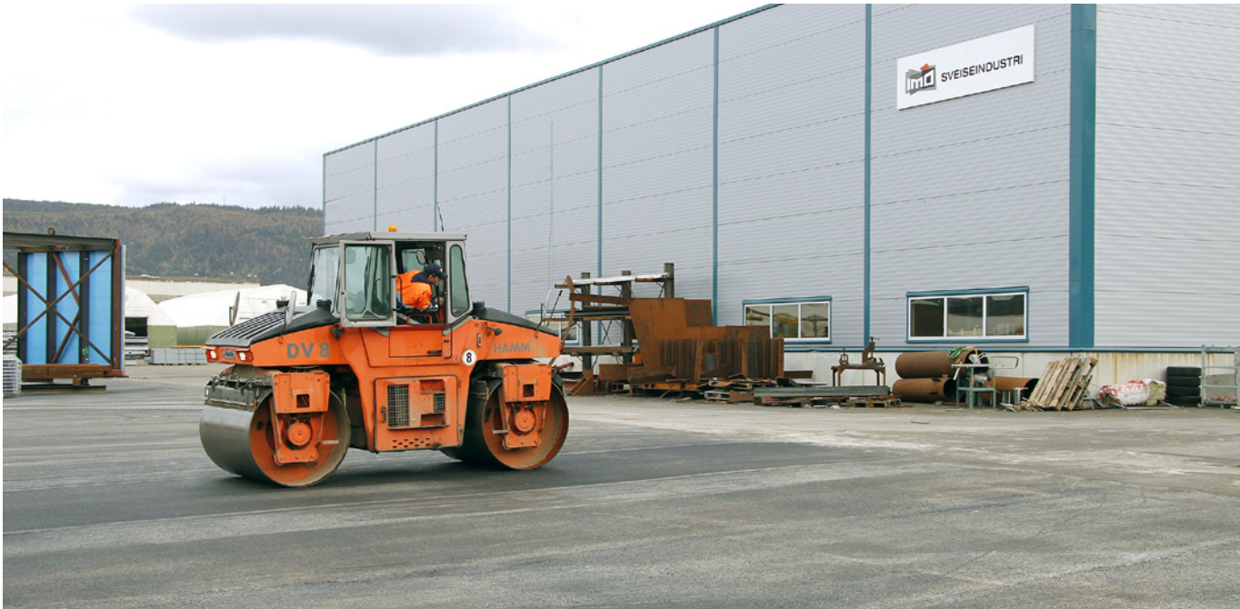
Asfaltering foran bygget til IMO Sveiseindustri AS.
