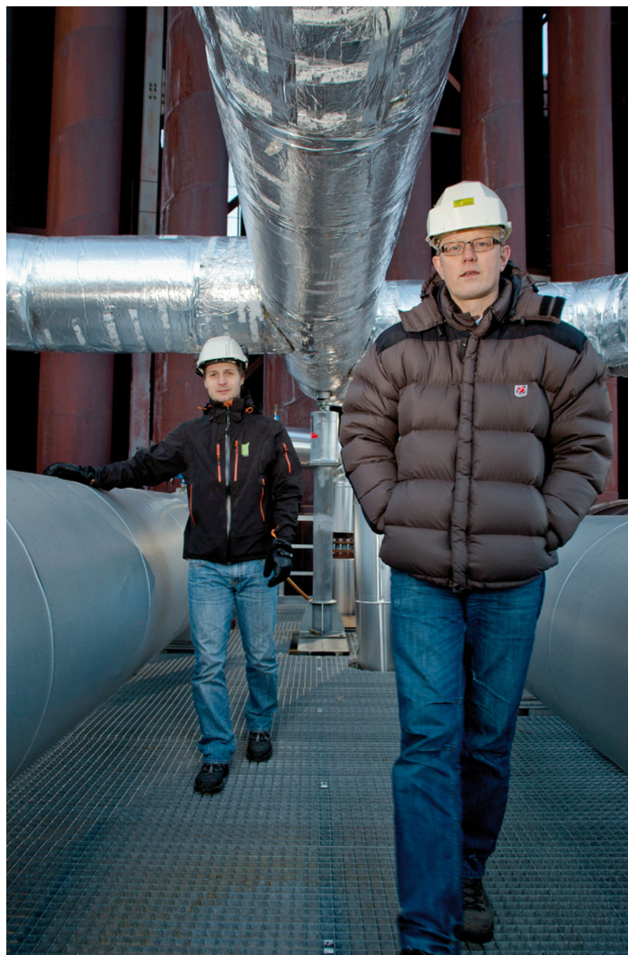
Driftsingeniør Ronny Straum (t.v.) og daglig leder Terje Sund-Olsen på plattformen over røykrørskjelen ved dampvekslerne.
