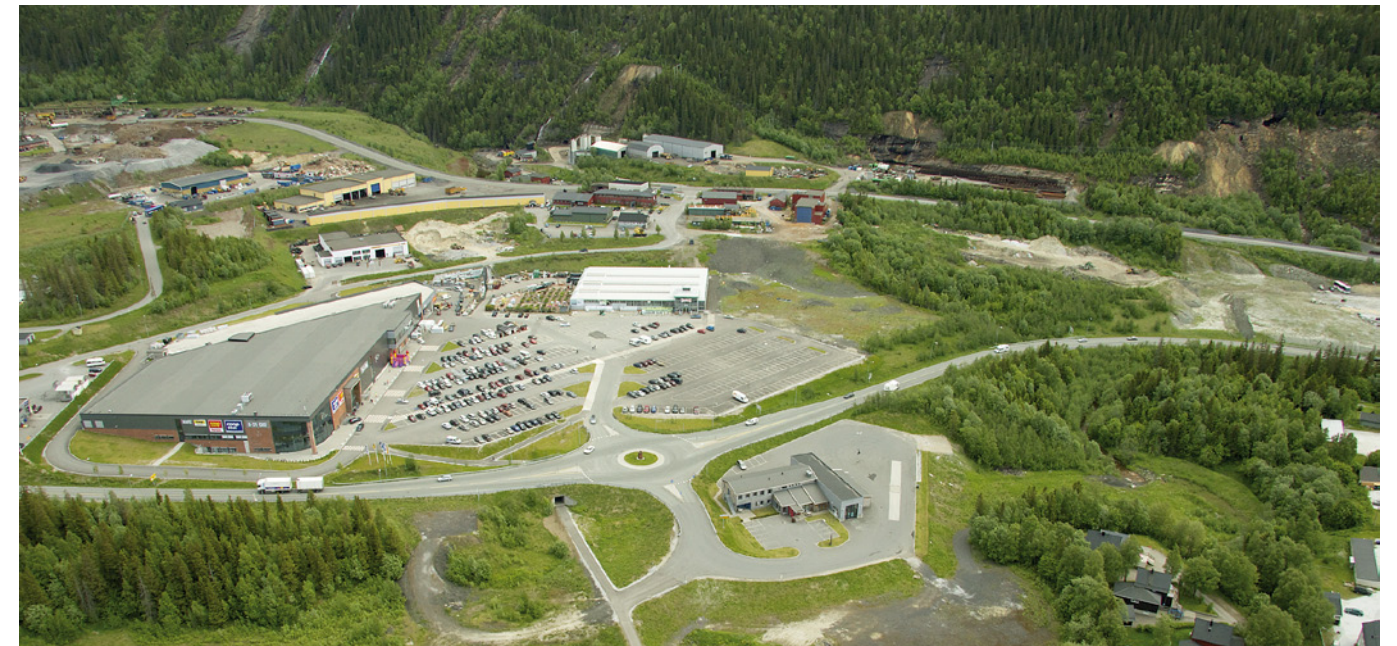
Opparbeidelse av tomteområdet ved Stigerplatået startet i 2012. Dette ligger til høyre for Plantasjens hvite tak, midt i bildet.
