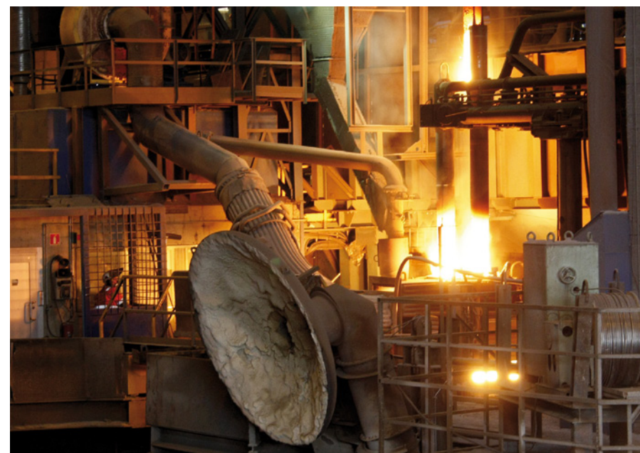
Fra stålverket ved Celsa Armeringsstål AS.
