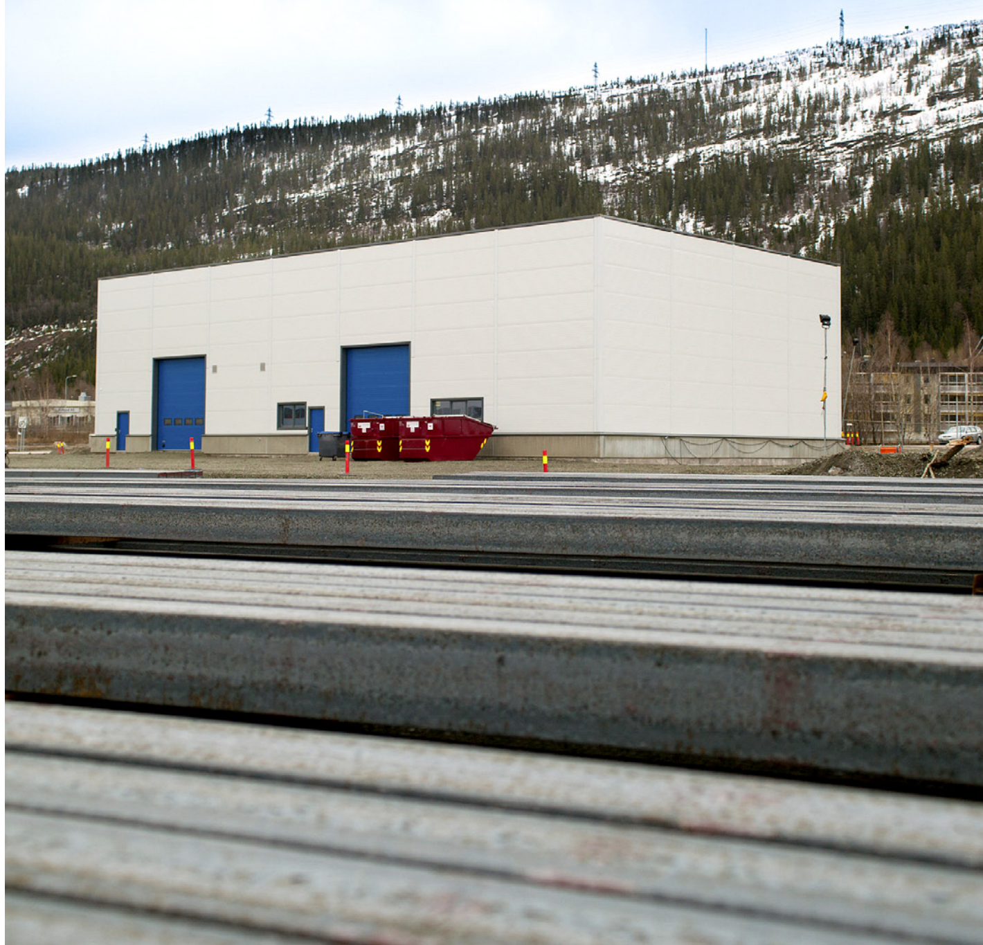
Nybygget til Helgeland Offshore ble påbegynt i 2011 og var ferdigstilt i månedsskiftet mars/ april 2012. Bedriften leier lokalene fra Mo Industripark AS, og den er lokalisert på Rana Industriterminal.
