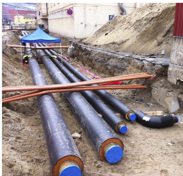
Det ble i løpet av 2011 lagt nye fjernvarmeledninger fra driftscentralen og fram til den nye kjelen ved røykgassanlegget til Fesil Rana Metall AS.
