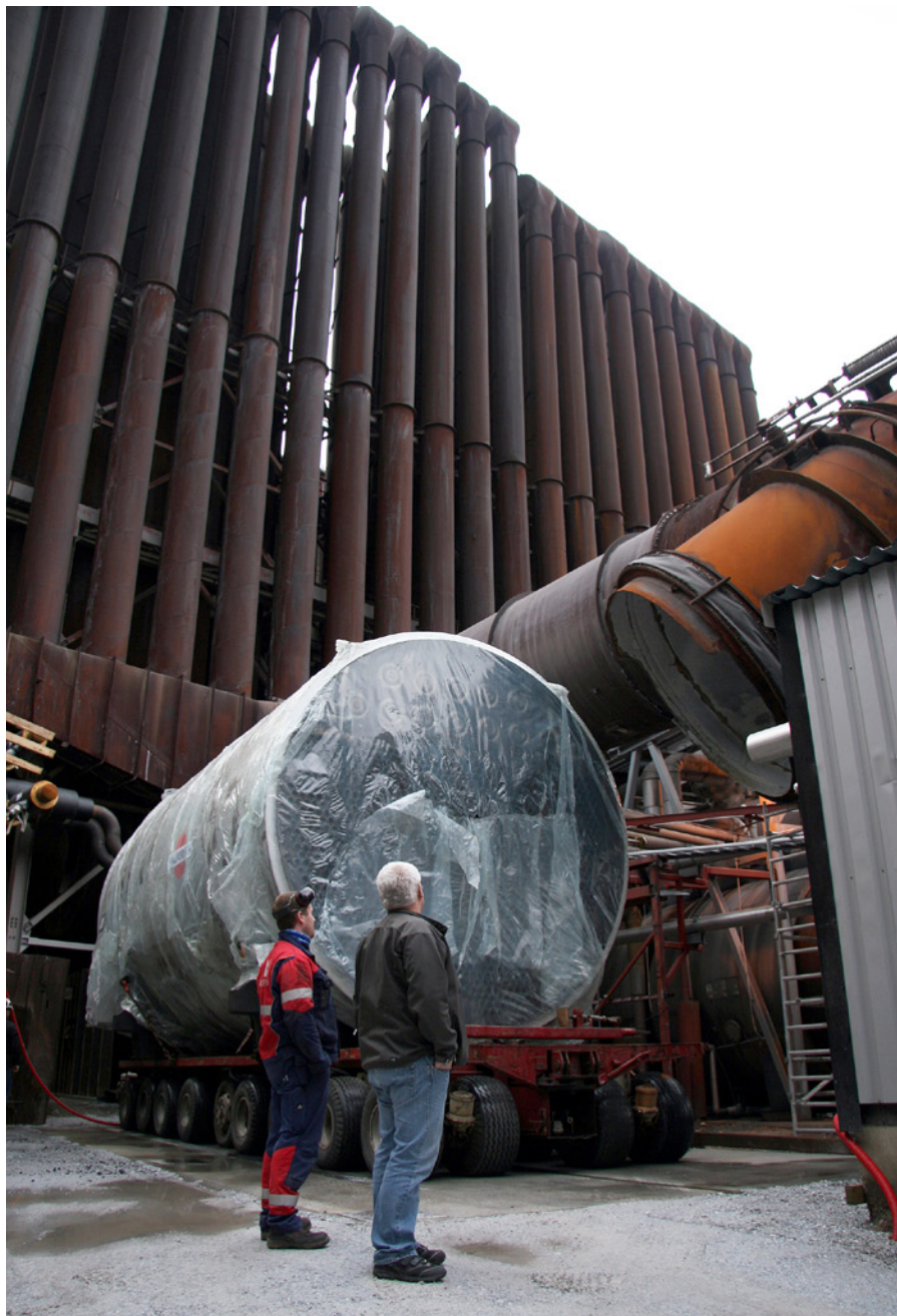
I 2011 ble et nytt gjenvinningsanlegg satt i drift, basert på overskuddsenergi fra Fesil Rana Metall. I slutten av september 2011 ankom røykgasskjelen, som er den sentrale delen i varmegjenvinningssystemet, og derved kunne monteringen kan starte.
