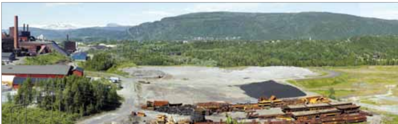
De nye deponiområdene i MIP Øst. Beplantningen reduserer støvflukt
