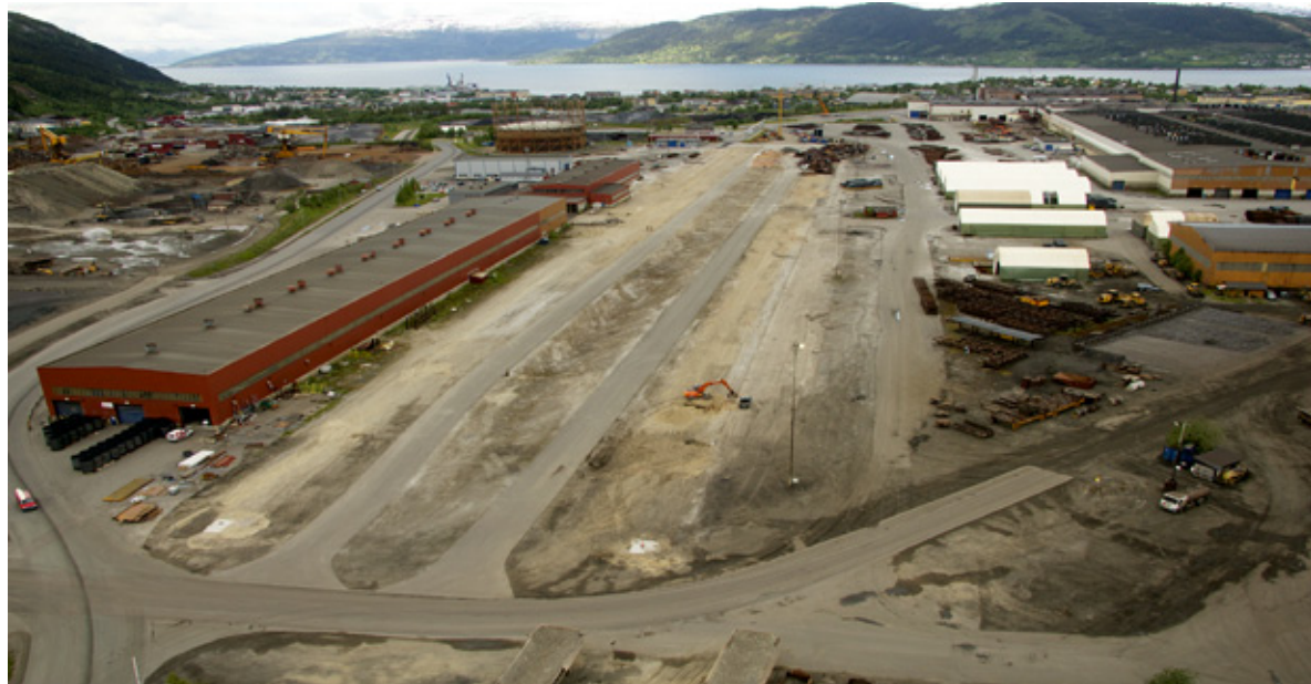
Sentraltomta i Mo Industripark, der rørene skal lagres.
