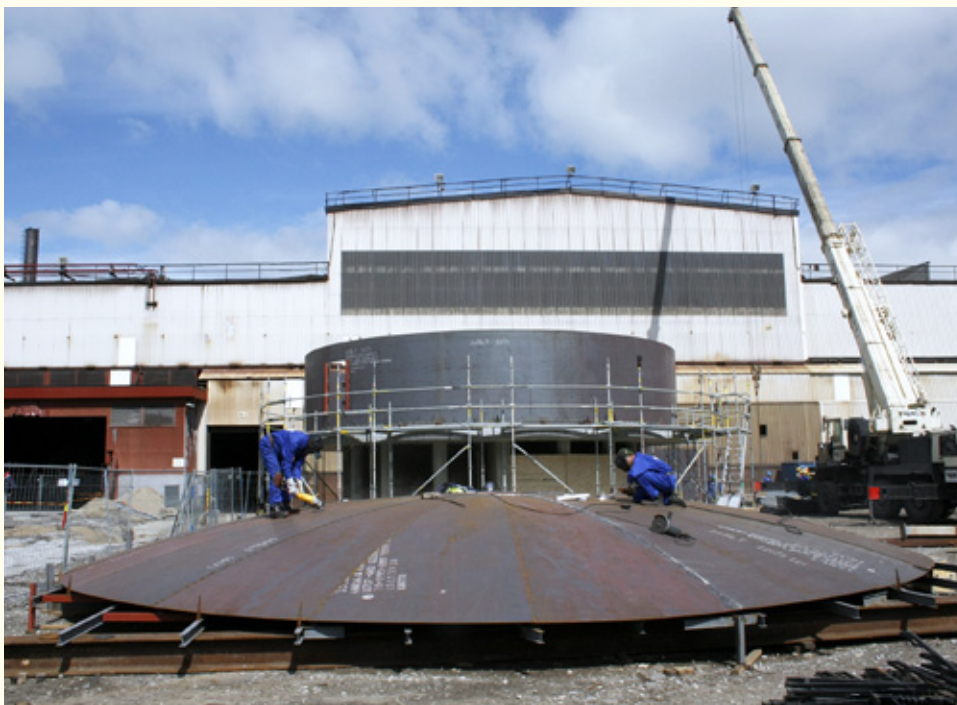
Tanken for flytende oksygen bygges utenfor der den tidligere emneovnen sto ved Ruukki Profiler.
