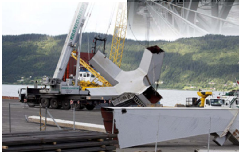
Siste rest – kranbeina – demonteres og gjøres klar for bortfraktning. Neste gang dette stålet skal ned på kaia, er som armeringsstål, slik buntene i framkant.
