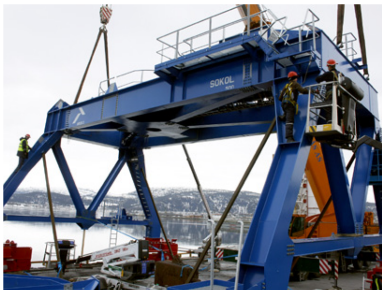
Montering av kranbeina er kommet godt i gang.
