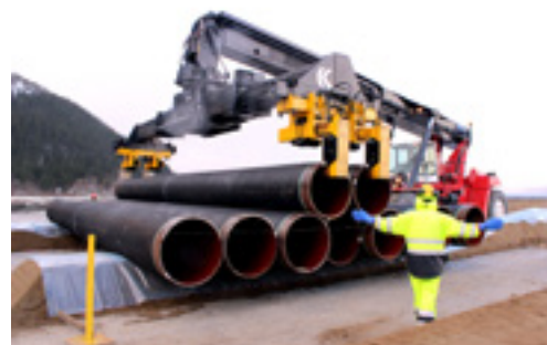
Effektiv utlegging fra Reach stackeren, der en operatør dirigerer slik at rørene legges pent på plass. Her legges det niende og tiende røret, og i alt er det plassert 4370 rør ut på lagerområdet.
