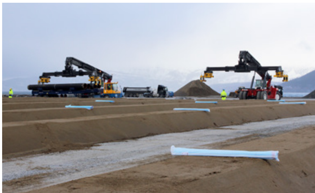
Reach stackere løfter av rørene fra trekkvogn med henger, for å kjøre dem inn og legge dem på senger av sand.
