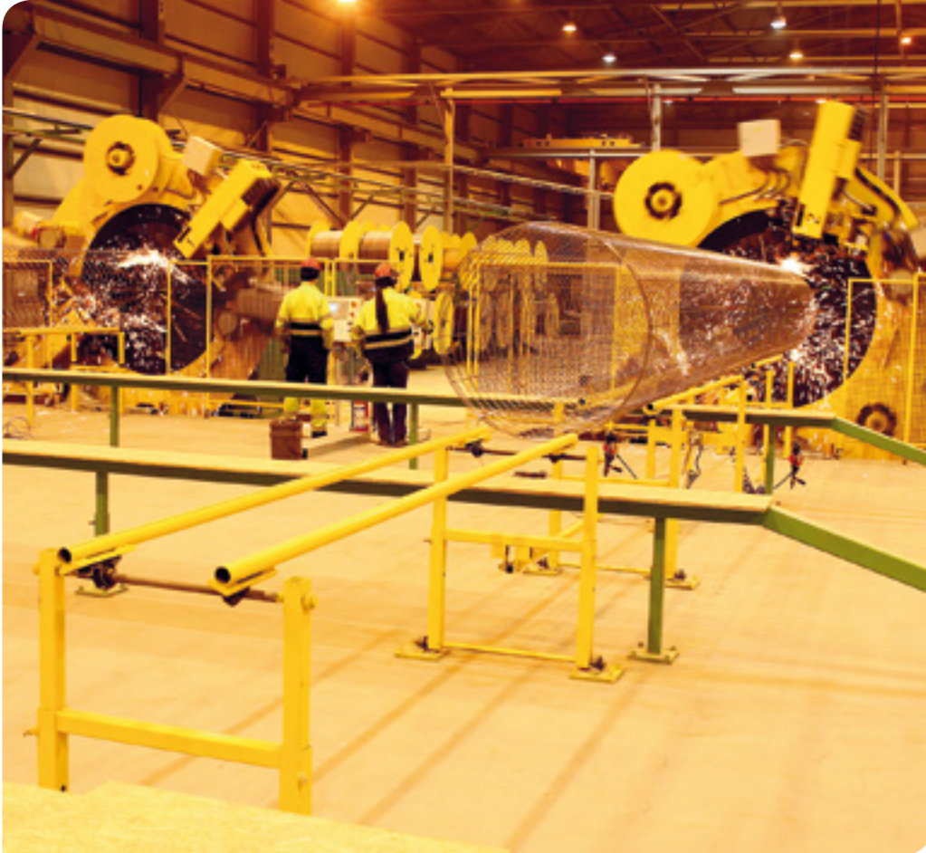
Rørene får et armeringsnett rundt seg før de belegges med betong. Maskinene som produserer dette er innkjørt og operatørene er godt i gang med drilling av prosedyrer.
