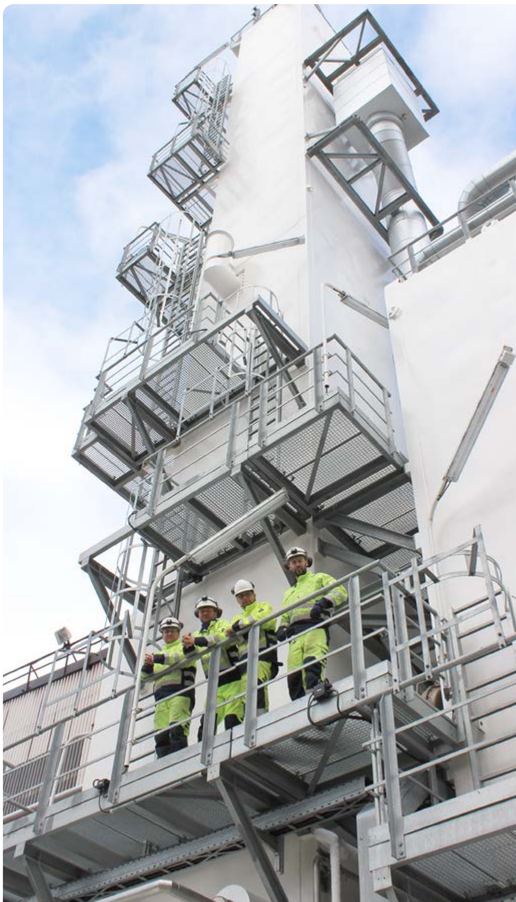
De fire ansatte ved den nye luftgassfabrikken til AGA i Mo Industripark, f.v.: Geir Thoresen, Lars Bjørkmo, Tom Stenwall og Andreas Morberg.
