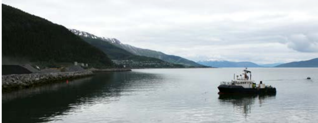
Borebas i aksjon med grunnboringer utenfor oppfyllingsområdet sør for Rana Industriterminal.
