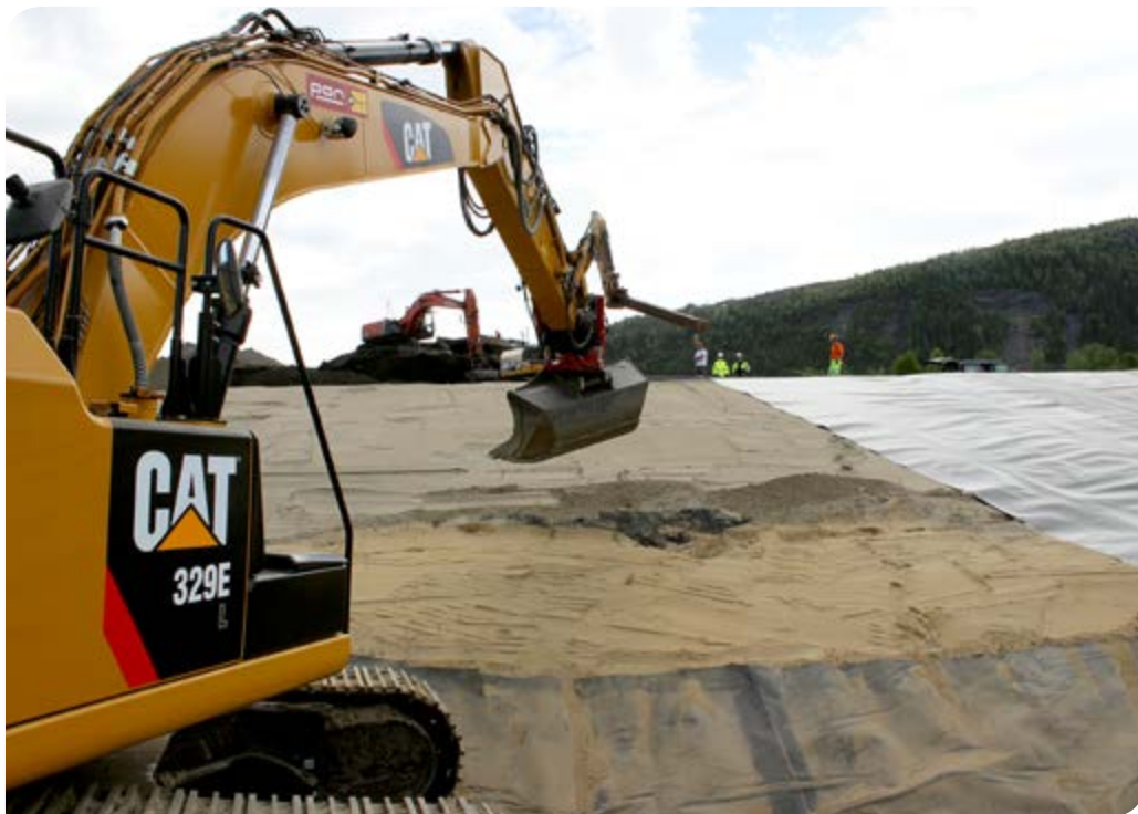
Det er HJH som har entreprisen med å lukke deponiet til Glencore Manganese Norway AS. De har (i begynnelsen av juni) i sving tre dumpere og tre gravemaskiner, samt en bulldozer.
