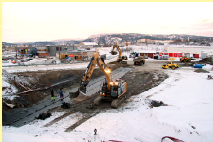
Bildet viser arbeidet med fundamentering, utført av Øijord & Aanes Entreprenørselskap AS.
