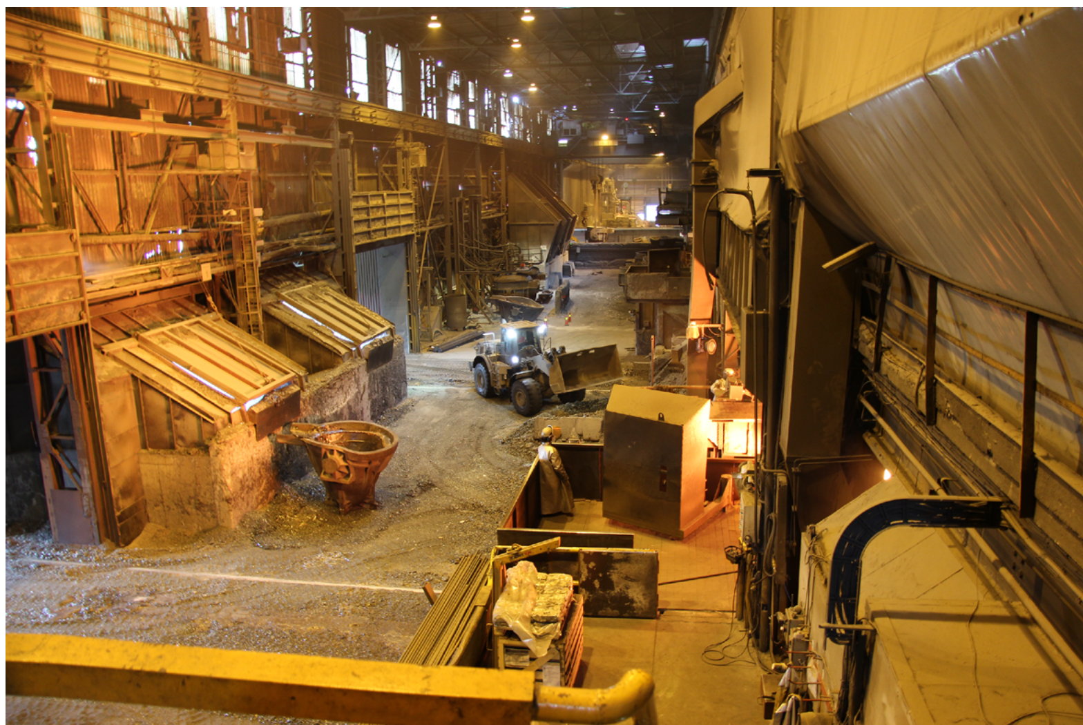
Ovn 1 gjøres klar til tapping. Etter ombyggingen vil den frastå modernisert og energibesparende. Det skal etter planen skje høsten 2016.
