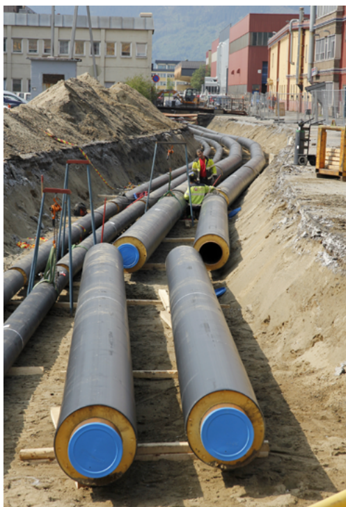
Vi skal aktivt fortsette arbeidet med gjenvinning og miljøetsatsing - og videreutvikler dette. Et av feltene er å utnytte potensialet vi har enda mer, blant annet for energigjenvinning til blant annet fjernvarme.
