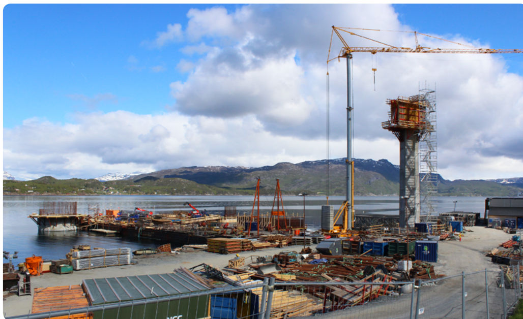
- Den lille snevre delen som stålproduktene utgjør i prosjekter innenfor bygg og anlegg kan utgjøre mye i forhold til de totale utslippene av CO 2 , sier Halvard Meisfjord. Bildet er fra Hålogalandsbrua utenfor Narvik, tatt i 2014.
