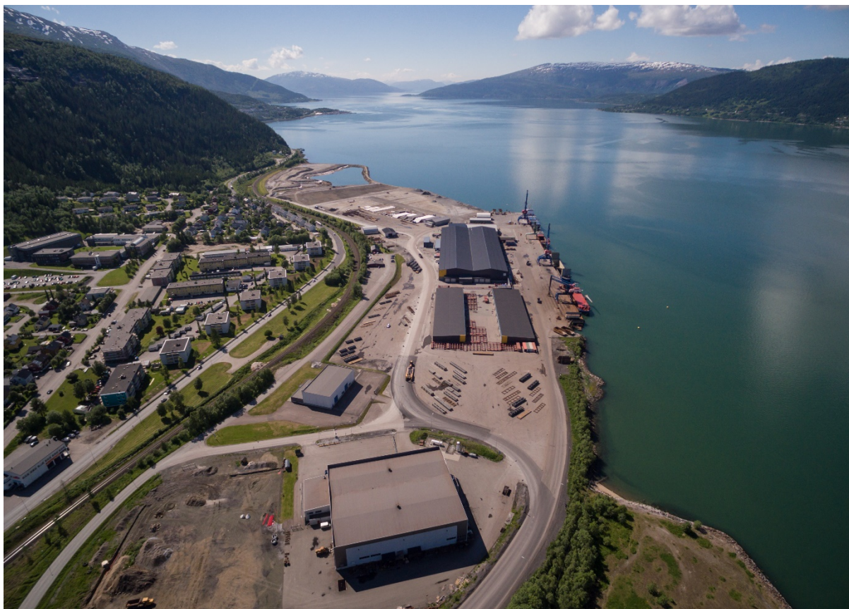
Figur 2-6: Planområdet sett fra øst. Rana Industriterminal er midt på bildet. Jernbanen, E6 og boliger i Langneset og Langneshøgda er til vestre for industriarealene. Grotnes Steel er i nedre del av bildet.
