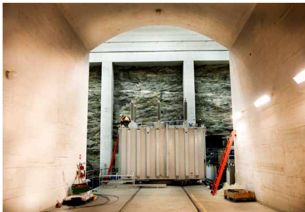
Det har vært et omfattende prosjekt å få den store transformatoren på plass inne i Svabo transformatorstasjon.
