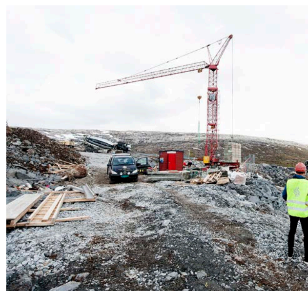
Arbeidet helt øverst ved vanninntaket pågår for fullt.
