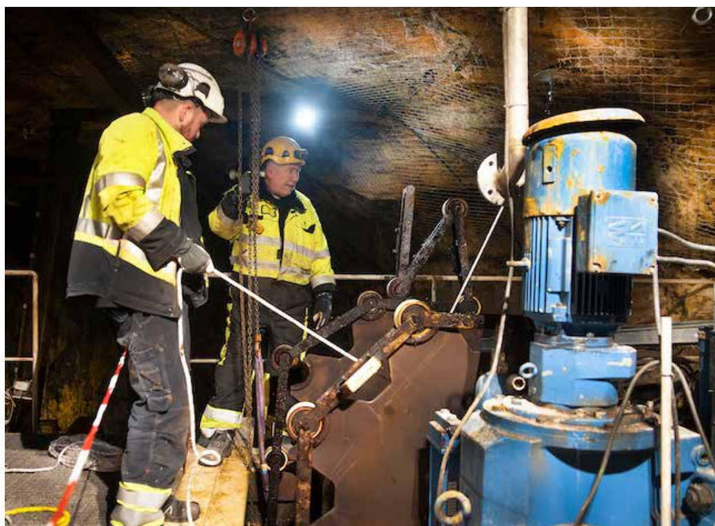
Prosessteknikerne André Nyjordet (t.v.) og Rolf Sivertsen ved MIP Energi under arbeidet med rensanlegget inne i Mofjellet. I front sees kjedeanlegget som Imtas måtte lage tilsvarende nytt av.
