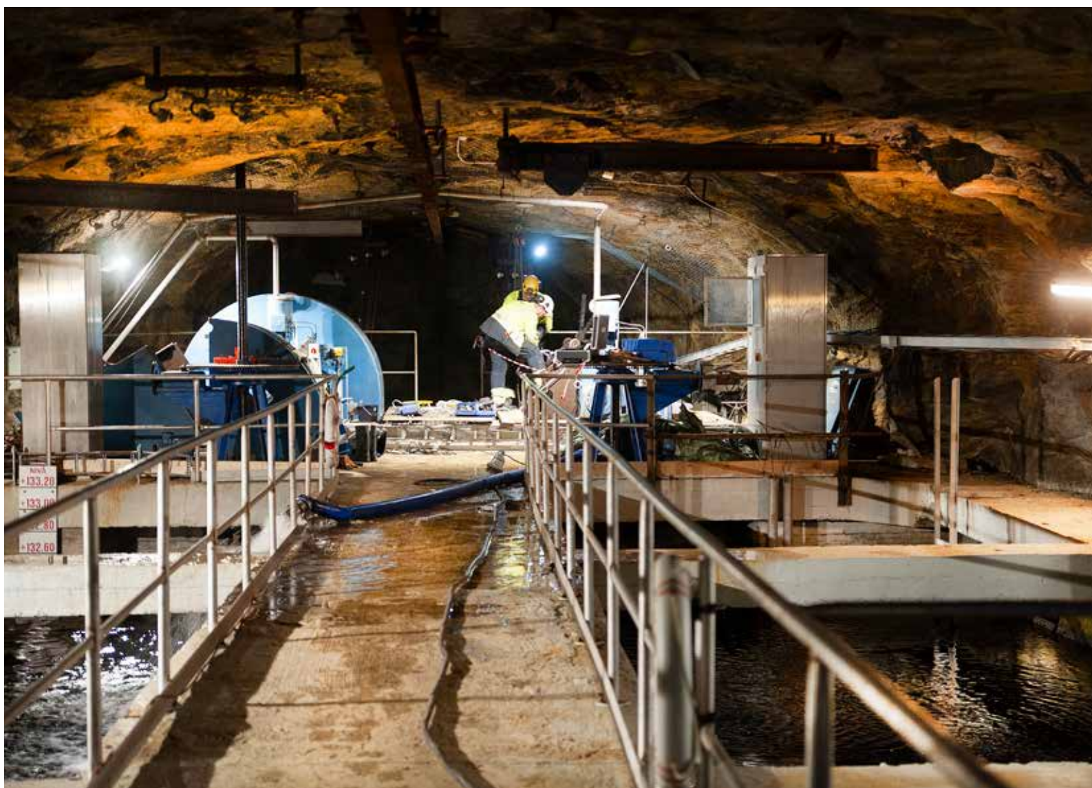
Vannverket med renseanlegg inne i Mofjellet forsyner Mo industripark med kjølevann og drikkevann.
