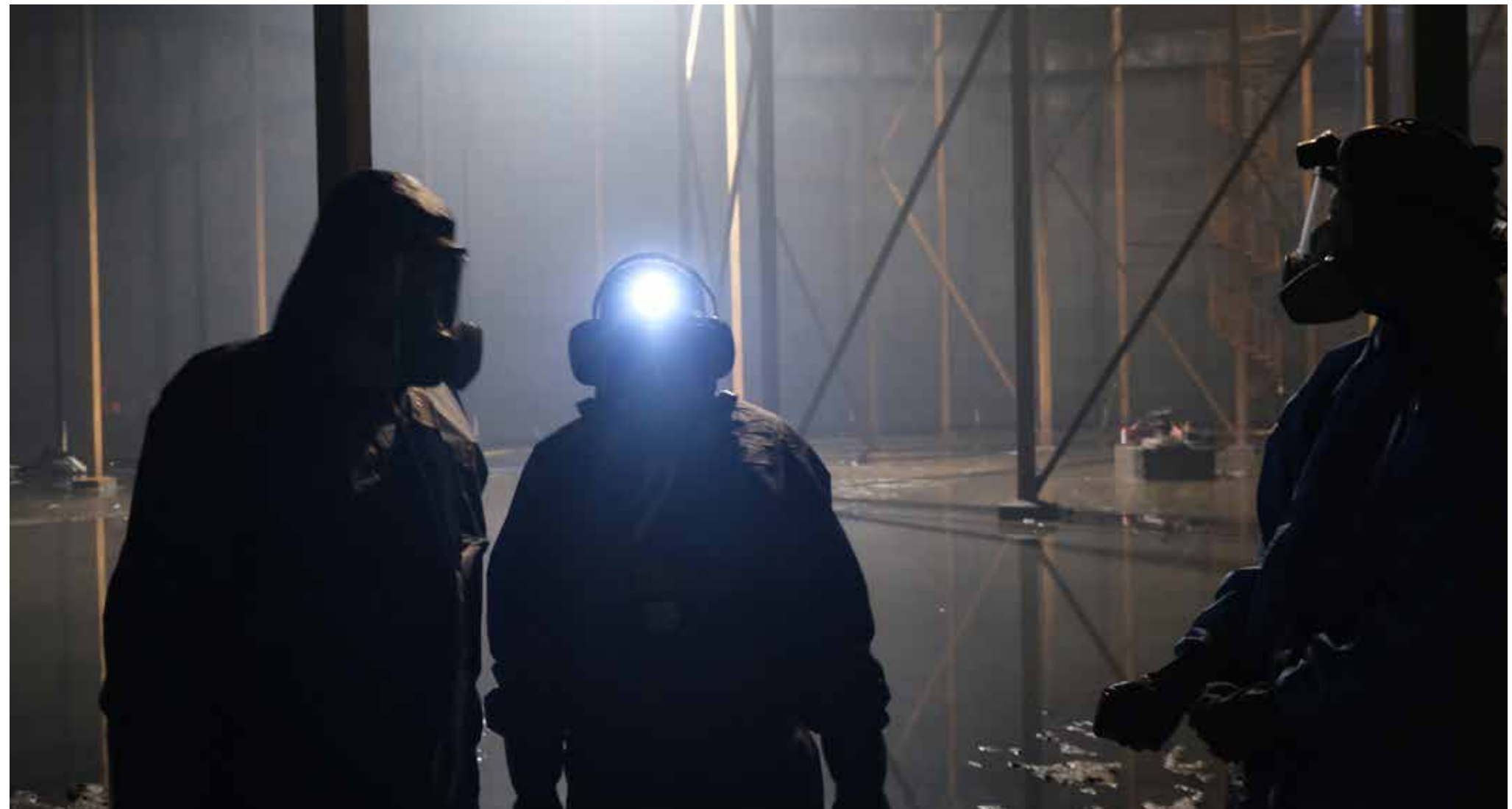
Grundige kontroller og vedlikehold både utenfor og inni gassklokka har pågått i rundt to måneder.
