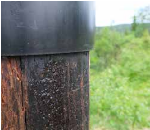
Kreosotstolpene på Storforsheilinja fases ut og erstattes med stolper i aluminium.
