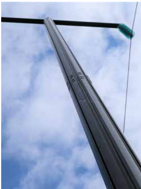
«Pilotstolpen» i aluminium kom på plass i sommer.
