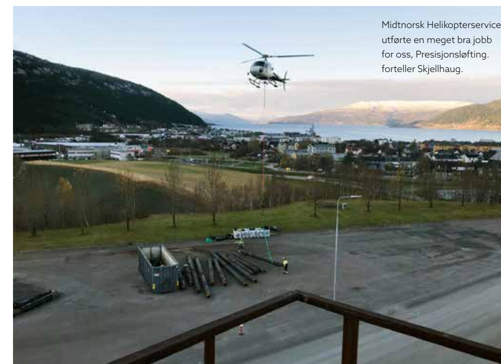
1320 meter fjernvarmerør likt det sorte røret i forgrunnen ble løftet ned. Her sammen med CO-gass nettet (grå store rør) i bakgrunnen.
