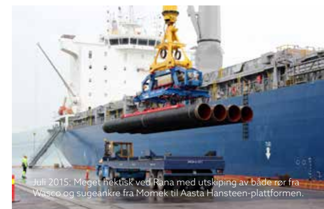
2011: Klargjøring av salve i dagbruddet ved Rana Gruber i et felt med 30 hull på 8 meter.
