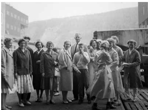
Besøk ved råjernverket, sinterverket og råmaterallageret. Kanskje i forbindelse med dagene da «Jernverksfolkets fruer» ble invitert på besøk. Da ble det en dag opprettet «barneparkering» ved resepsjonen. Vårt Verk nr. 1-1956
