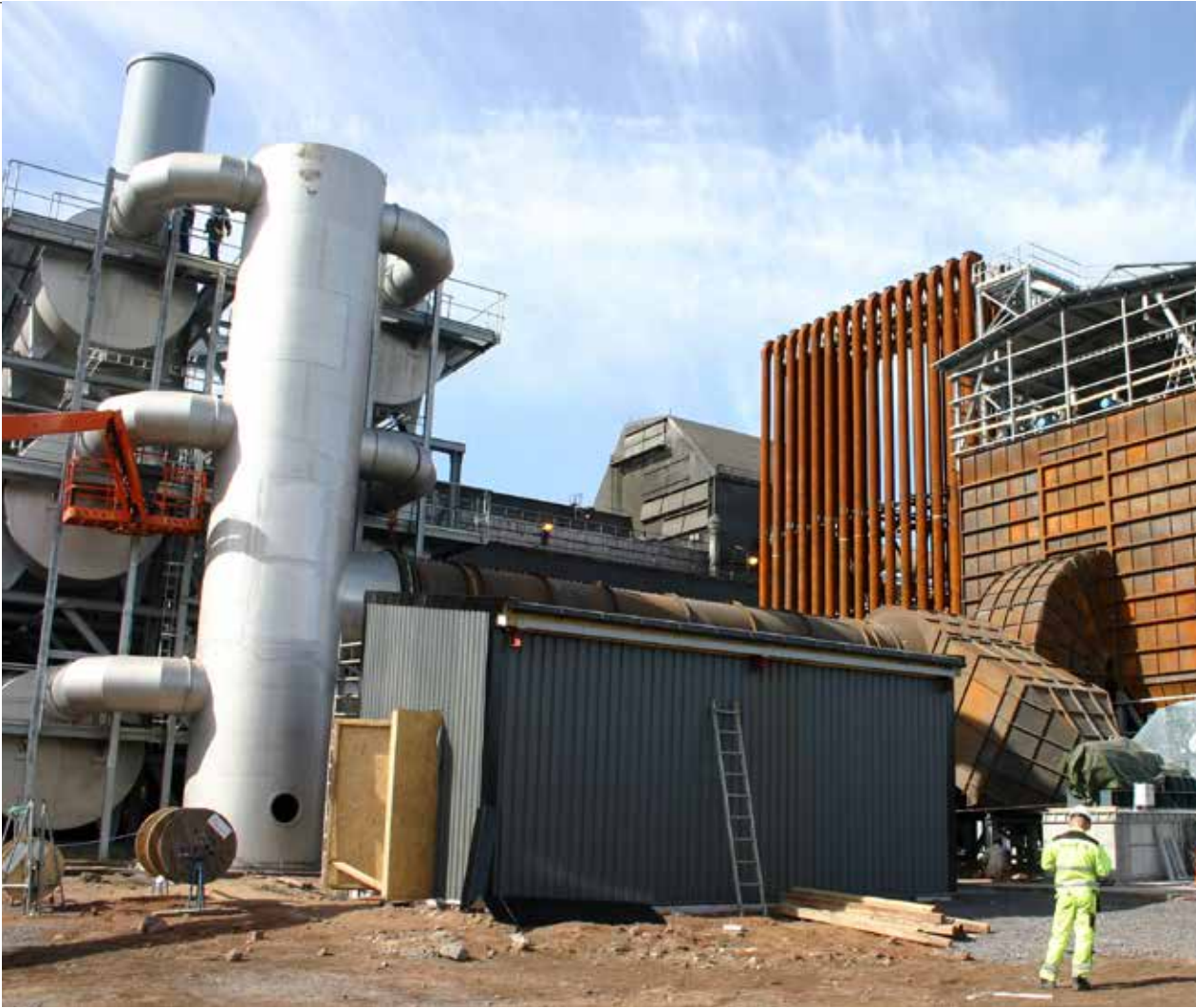
Oppføringen av det nye renseanlegget ved Celsa Armeringsstål pågår. Bildet er fra mai 2008, samme år som anlegget kom i drift.
