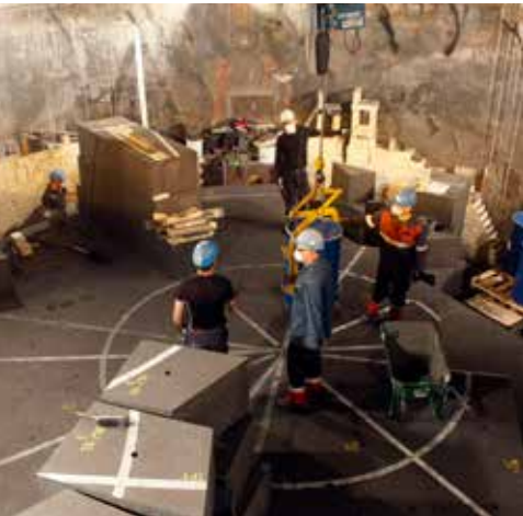
Fesil Rana Metall satset langsiktig i Rana ved investeringer i en forbedret ovn 6 ved ommuring i 2003 som forbedret både prosess, sikkerhet og miljø. Dette ble også gjort ved ovn 5 og gjentatt ved ovn 6 i 2013, der dette bildet er fra.
