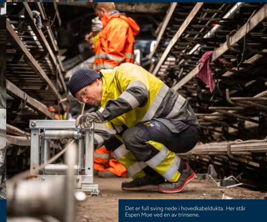
Her er trinsesystemet som kabelene trekkes gjennom.
