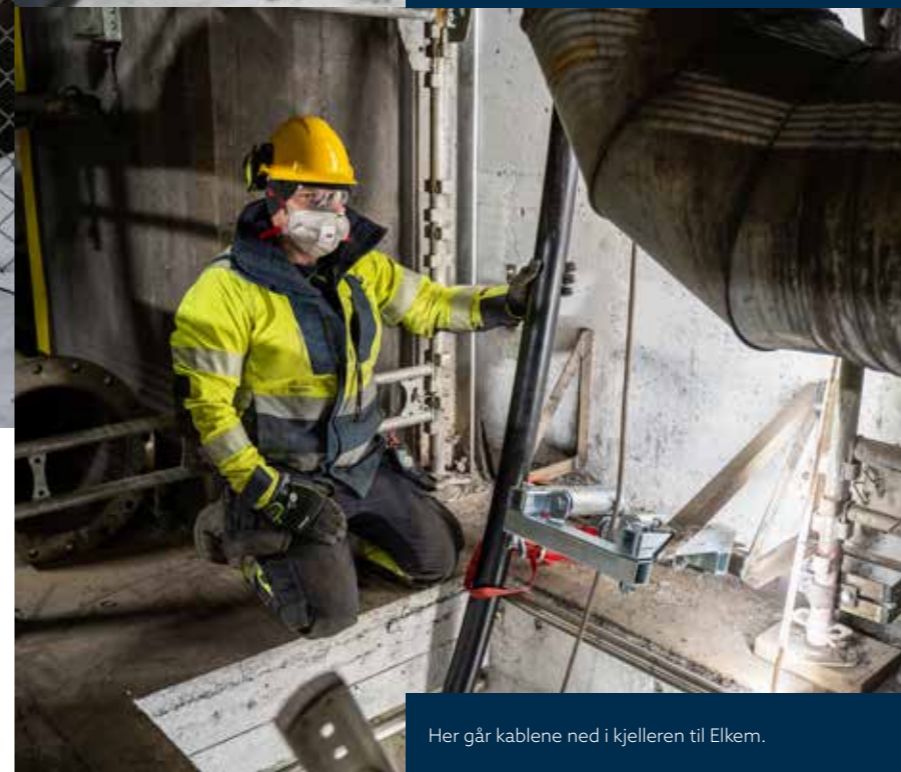
Her går kabelen ned i rør under bakken og bort til hovedkabeldukta.
