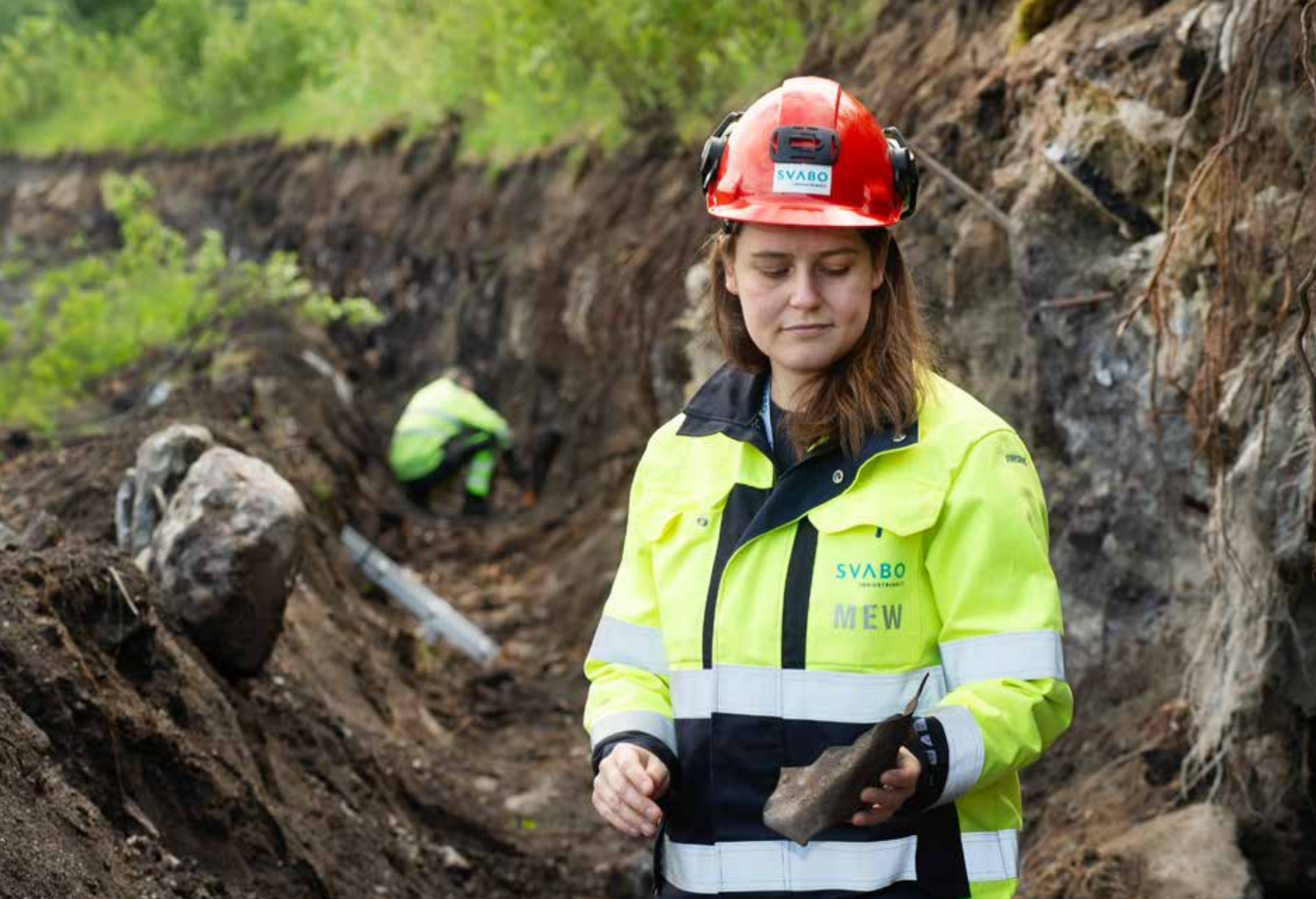
Prosjektleder i Svabo Industrinett, Marte Wea, undersøker en bit skrap som de har funnet i grøfta.
