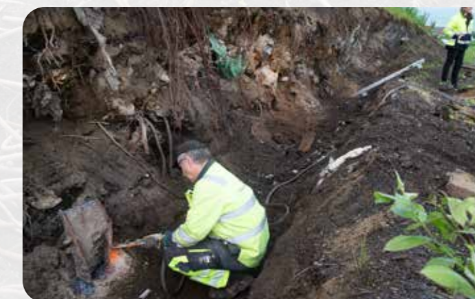
Maskinkjører og reparatør i Anleggsservice, Dag Arne Myrheim må ta sveiseapparatet fatt for å fjerne en stor bit armeringsjern.
